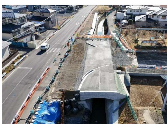
【工事の進捗状況(令和6年11月時点)】
