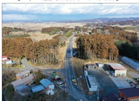
【工事の進捗状況(令和7年1月時点)】
