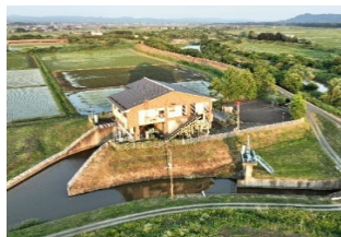
野谷地排水機場
