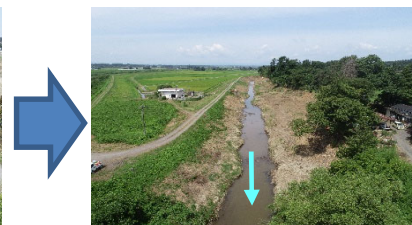
瀬峰川（支障木撤去後）
